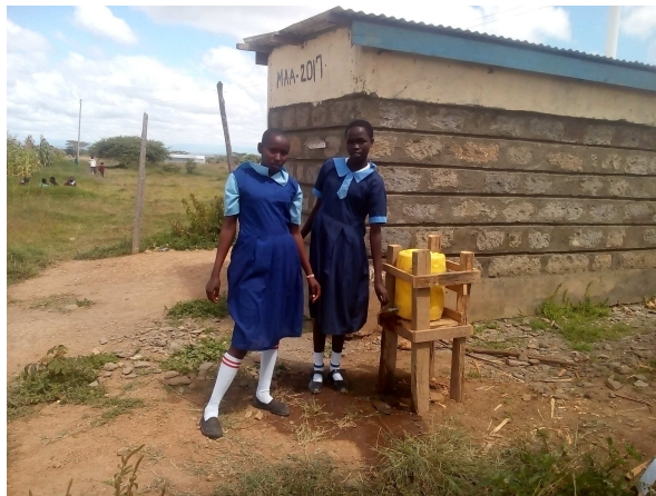
Système de lavage des mains, par les élèves, après utilisation des WC. Les WC ont été aussi construits par MAA en 2017.
