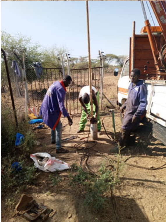
Ils enlèvent la pompe souterraine à 140 m sous terre. Elle est « grillée » !
