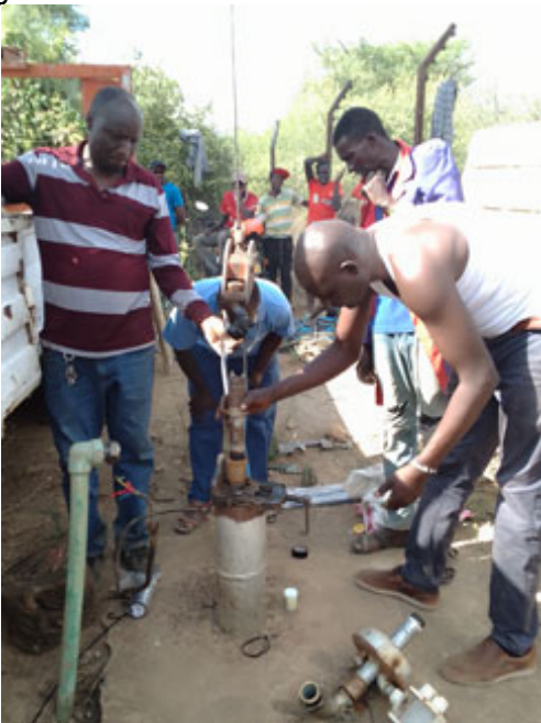
On repose la nouvelle pompe.
