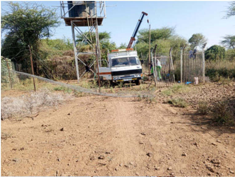
La compagnie de forage sur place
