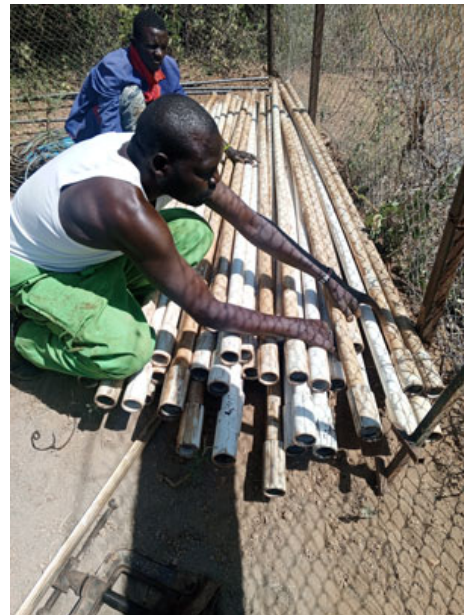
Achat des tubes pour descendre 15m de plus en profondeur et trouver l'eau qui a reculé.
