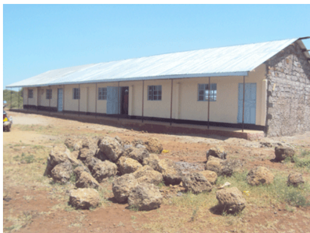
2 nouvelles classes à Engasakinoi, Rombo en 2013, et la 3 e construite par MAA en 2012.
