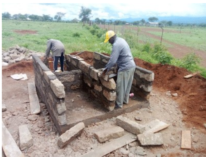
Construction de 4 latrines à Esukuta primary.
